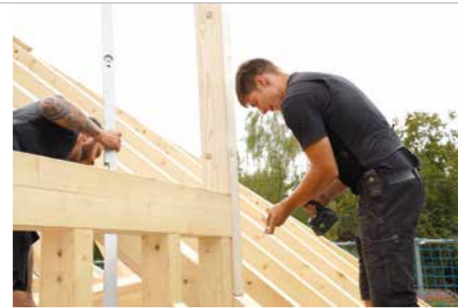
Die Mitarbeiter beim Erstellen eines Dachstuhl.
