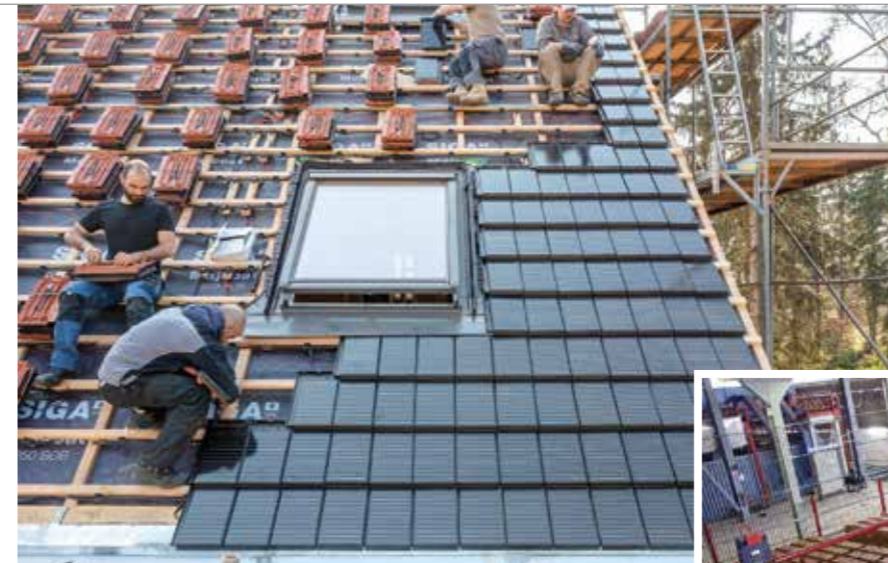
Lichtblick: Der Bereich Photovoltaik bietet Dachziegelherstellern gute Chancen.
