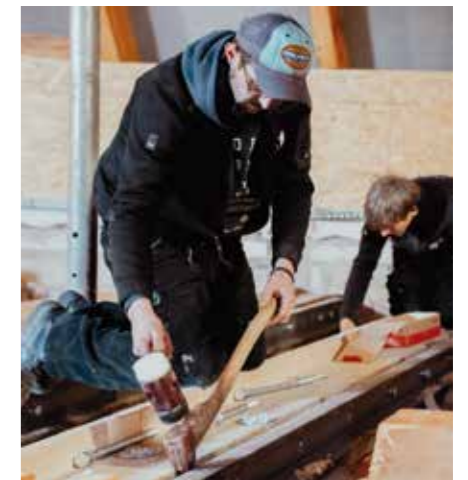
Mitarbeiter sanieren einen Dachstuhl.
