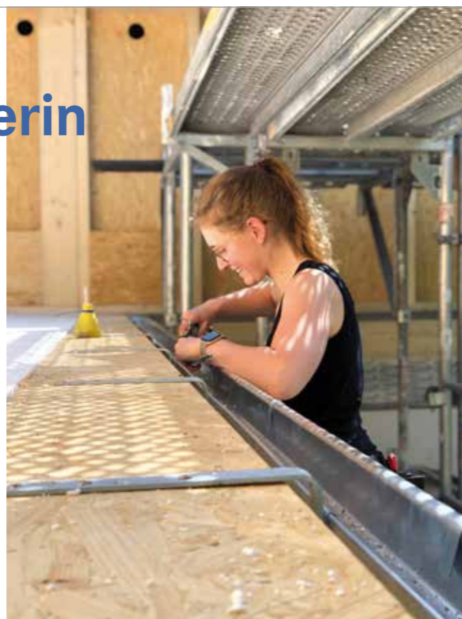
Genaueres Arbeiten ist auch an einer Dachrinne gefragt.
