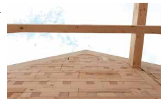
Auch im Dachgeschoss kommen Holzbausteine für die Zwischenwände zum Einsatz.
