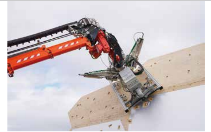
Der Roboter-Spinnenkran beim Einsetzen der Holzleichtbauteile.
